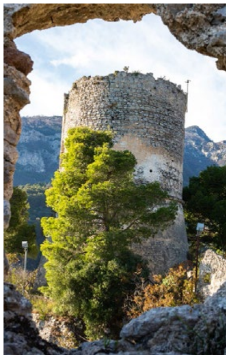
▲ Wieża Torre dello Ziro
